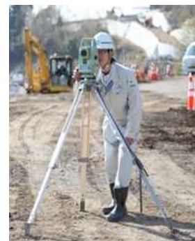
土木技術者 現場での測量作業の様子
