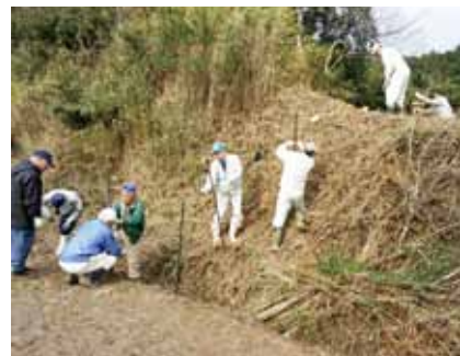
電柵の設置状況
