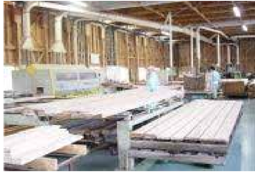
羽目板・フローリング加工
